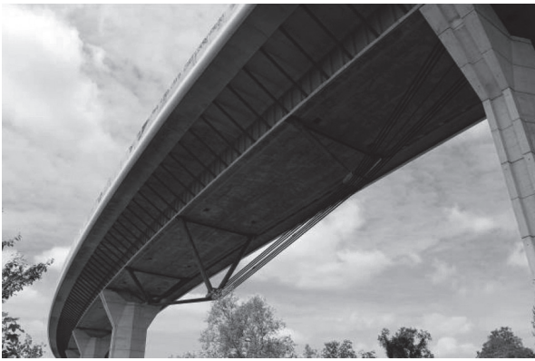
写真 - 15 モー高架橋
