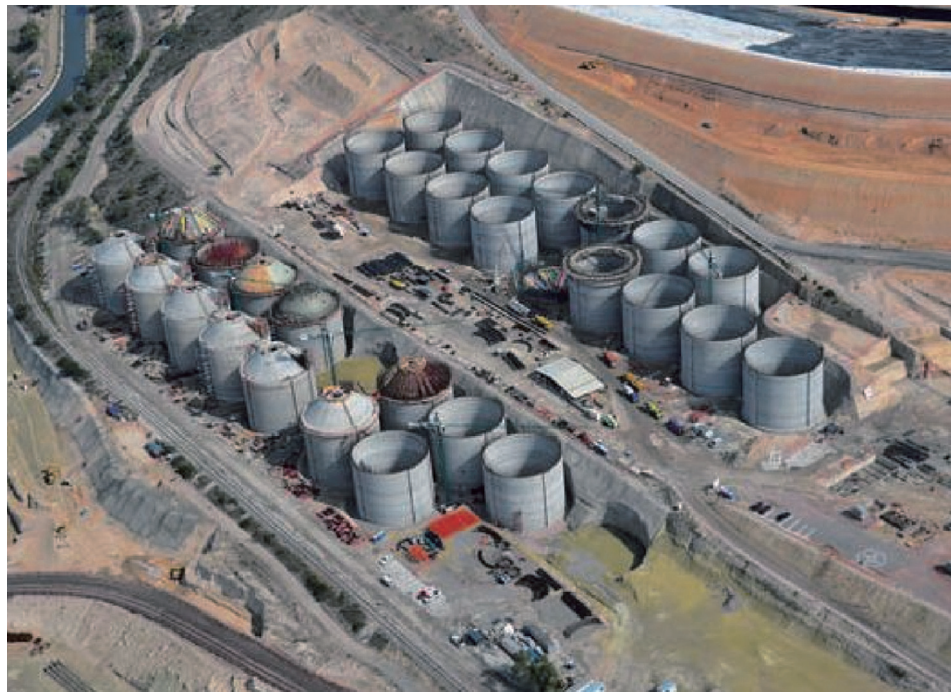
図 - 9 建設中の航空写真
