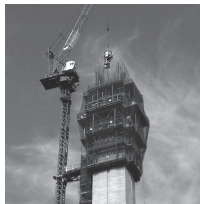
写真 - 5 バケットによる打設状況
