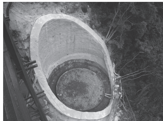
写真 - 1 竹割り型構造物掘削工法
