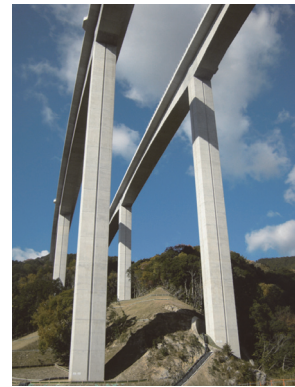
写真 - 9 完成写真 (2012 年 11 月)
