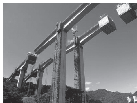
写真 - 7 張出し架設工の施工状況
