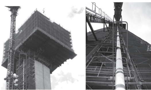
写真 - 6 鉛直配管の設置状況 (下り線 P3)
