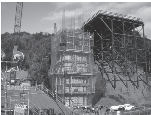
写真 - 4 クライミングフォーム組立状況
