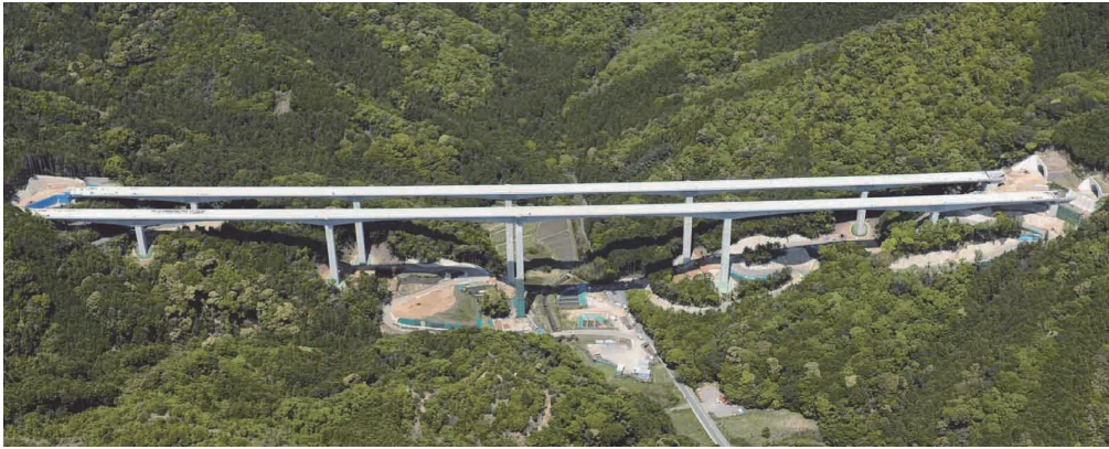
写真 - 8 地形改変面積を最小化した工事用道路
