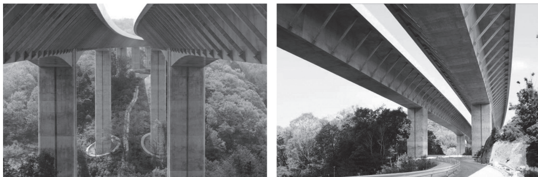
写真 - 10 完成写真
