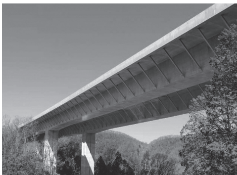
写真 - 1 完成写真 (P5-P6間)
