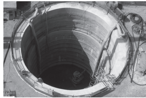
写真 - 3 掘込み部+大口径深礎施工状況
