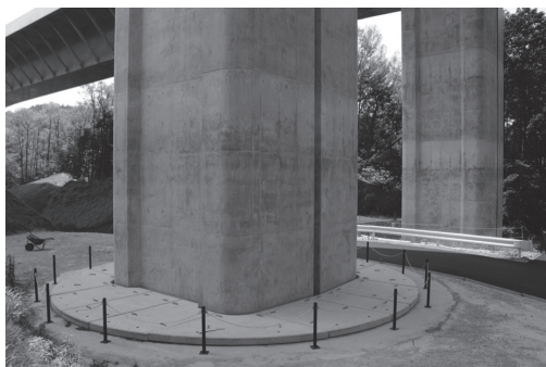
写真 - 5 掘込み式橋脚完成写真
