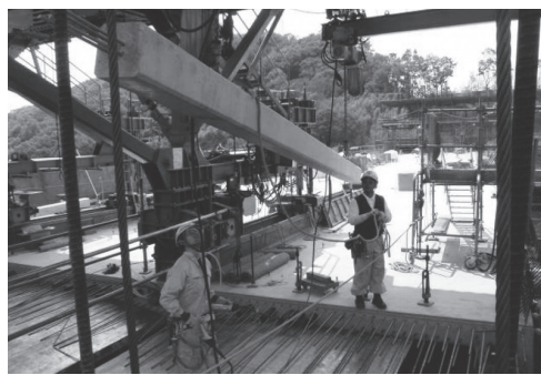
写真 - 7 ストラット設置状況
