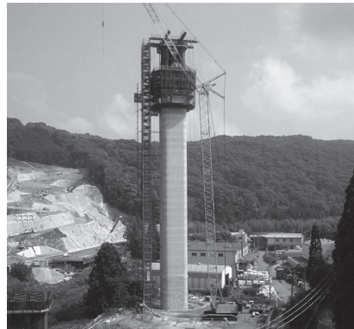
写真 - 3 HSF 工法による橋脚の施工
