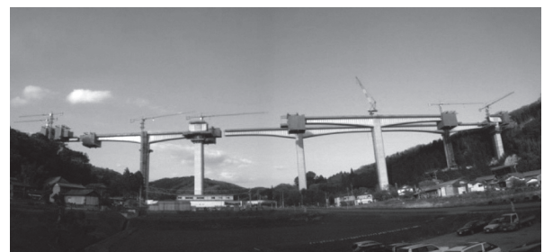
写真 - 4 クレーン設置状況
