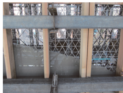
写真 - 5 透明型枠を用いた充填確認状況
