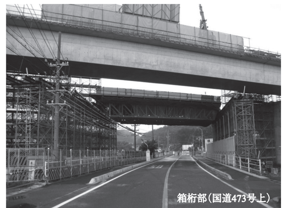
写真 - 10 固定支保工横移動状況（移動完了時）
