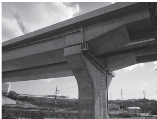
写真 - 1 2主版桁と箱桁の連続部分
