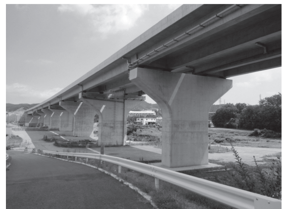
写真 - 11 完成写真
