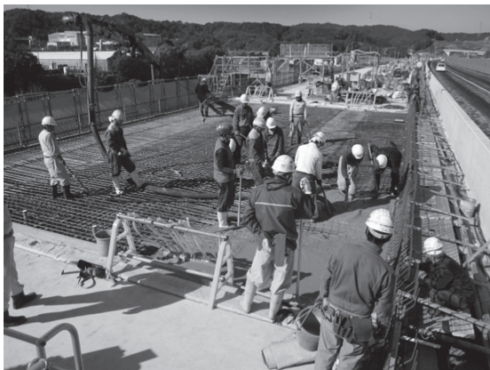
写真 - 6 コンクリート打設状況（下り線 P6-P7 間）
