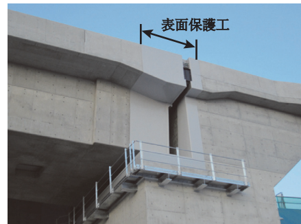
写真 - 4 コンクリート表面保護工施工状況
