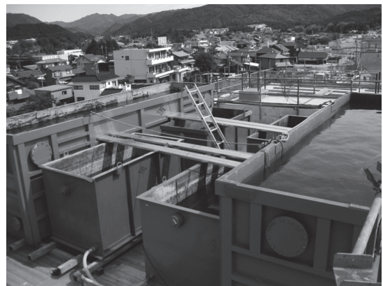
写真 - 8 実物大載荷試験状況
