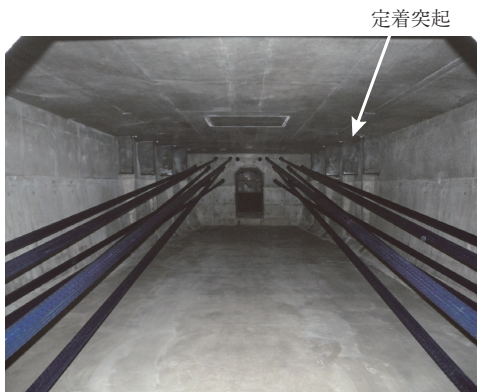
写真 - 2 外ケーブル配置状況 (P7 支点)
