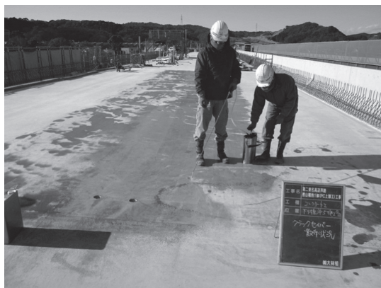
写真 - 7 収縮低減剤散布状況
