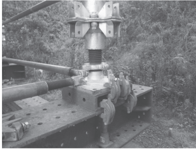
• ローラー設置前
