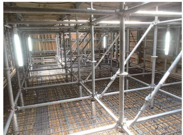
写真 - 4 桁内支保工組立状況
