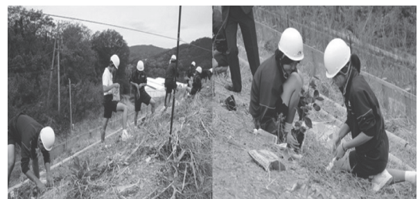
写真 - 3 のり面への苗木の植樹状況
