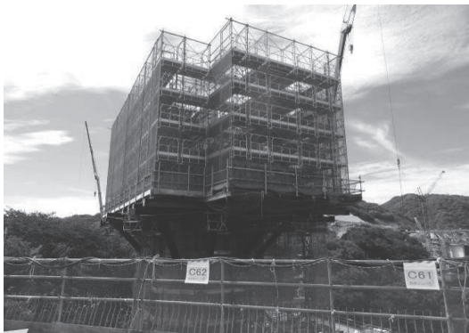
写真 - 2 移行部上部工から望む隣接橋脚施工状況
