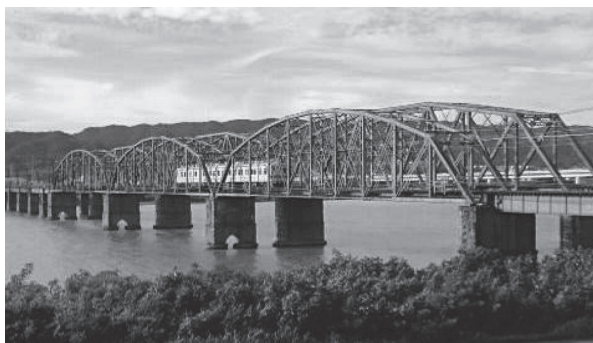
写真 - 8 紀ノ川橋梁と南海電車(手前が上り線)
