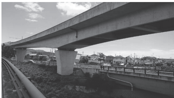
写真 - 7 第二阪和国道 山中川東高架橋
