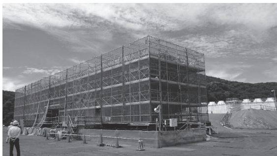
写真 - 4 分合流部 DP5 橋脚（手前）～ DP4 橋脚（奥）
