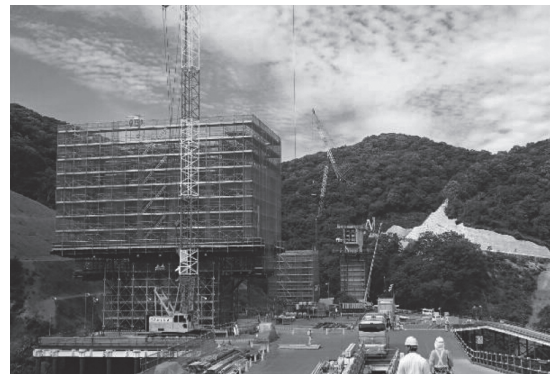
写真 - 5 分合流部 DP3 橋脚（手前）～ DP1 橋脚（奥）
