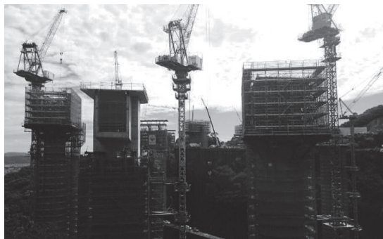
写真 - 3 分合流部から移行部・D ランプ橋工区を望む
