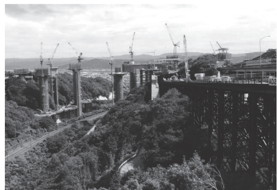
写真 - 1 移行部工区全景
