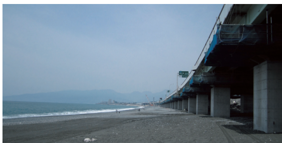
図 - 1 調査対象橋梁
