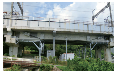
写真 - 5 試験施工完了後の状況
