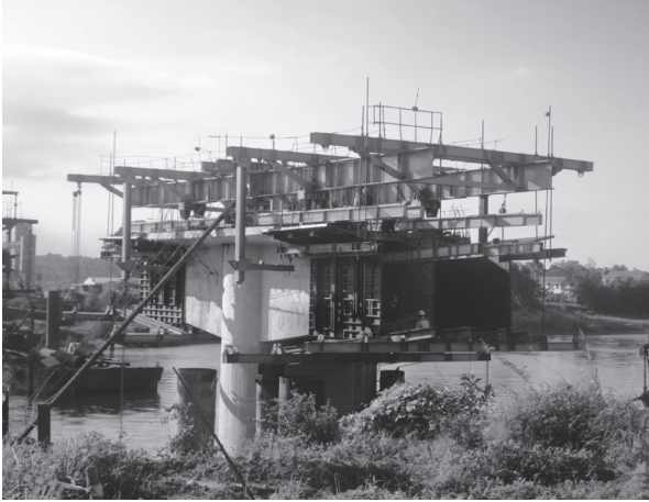
写真 - 5 張出し施工時の状況
