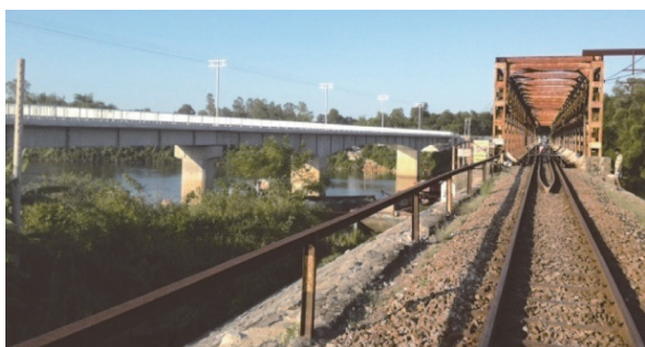
写真 - 3 新旧ソノボ橋
