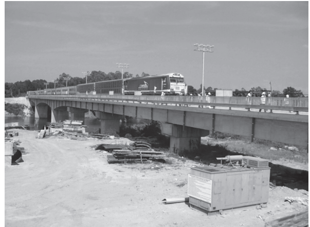
写真 - 6 たわみ計測状況
