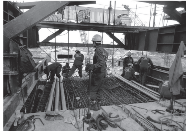
写真-4 鉄筋・シース組立状況
