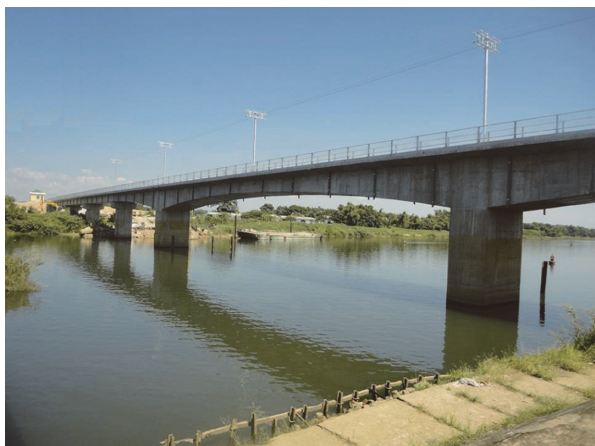
写真 - 2 新ソノボ橋
