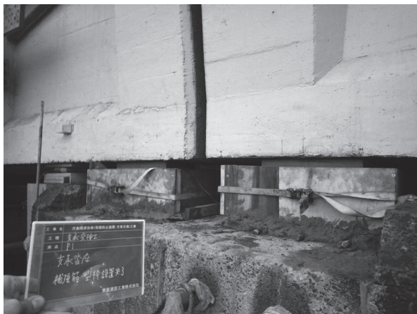
写真 - 7 沓座モルタル用型枠設置状況
