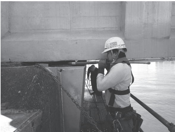
写真-10 フラットジャッキ配管作業状況
