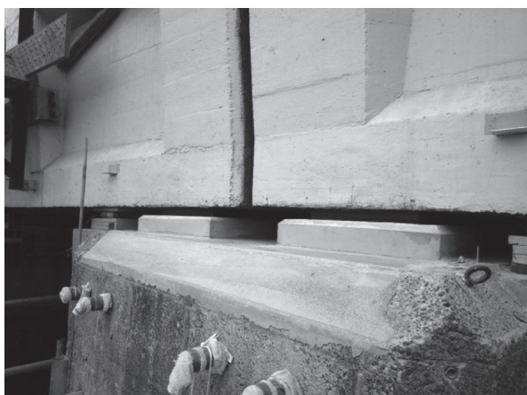
写真 - 8 はつり部復旧後 P1 橋脚支承部
