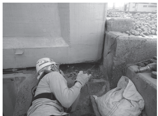
写真 - 6 支承周辺のはつり状況
