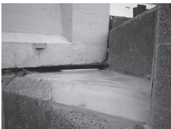
写真 - 9 はつり部復旧 A2 橋脚支承部
