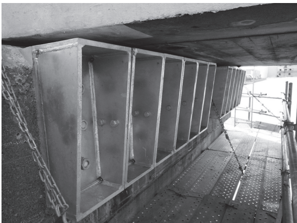
写真 - 3 縁端拡幅ブラケット設置状況
