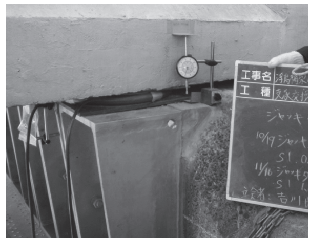
写真 - 5 高さ管理状況
