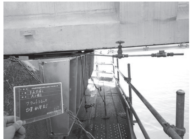
写真 - 4 フラットジャッキ設置状況
