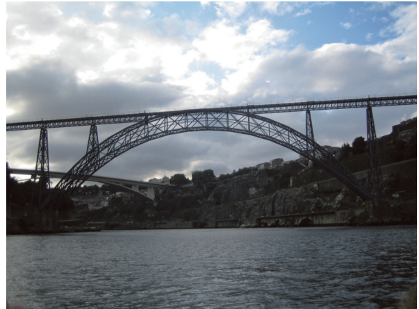
写真 - 6 マリア・ピア橋
