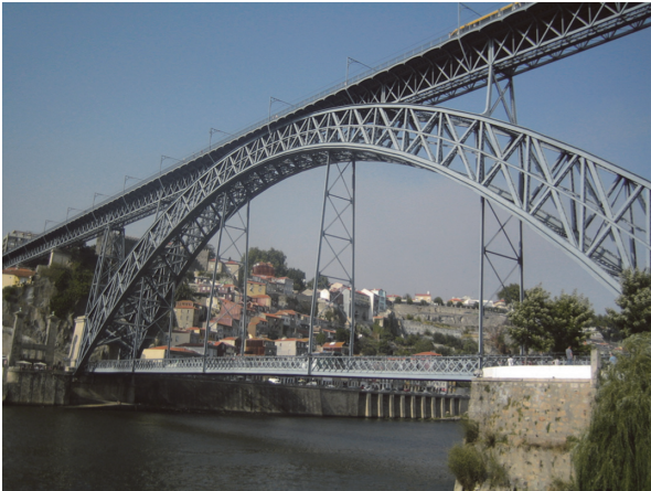
写真 - 4 ドン・ルイス I 世橋
