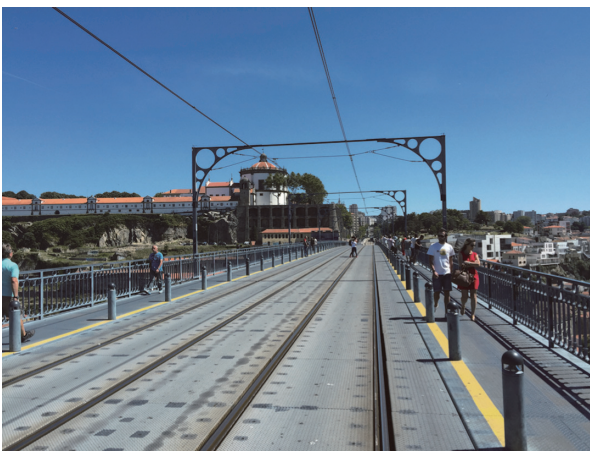
写真 - 5 歩行者とメトロにより利用されているドン・ルイス I 世橋の上層
