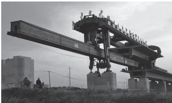
図 - 12 2スパン下支え式架設桁型ランチャーによる 32.7 m, 9 000 kN 複線用箱桁の架設 (写真提供: BWM)
