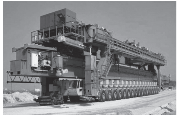
図 - 13 タイヤトローリーによる架設桁と下支え式架設桁の再配置 (写真提供: BWM)
