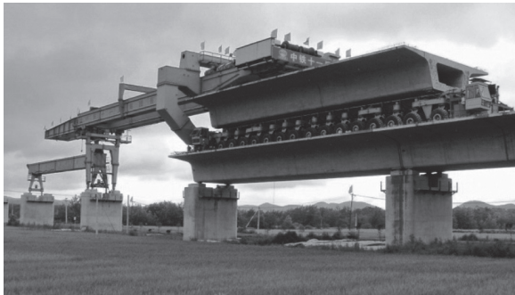
図 - 11 伸縮式ランチャーによる 32.7 m, 9 000 kN 複線用箱桁の架設 (写真提供: BWM)
