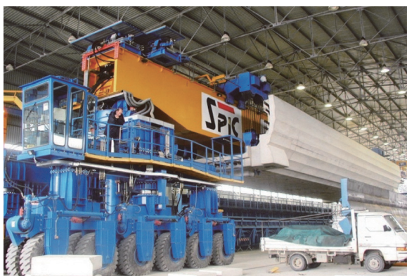
図 - 8 旋回トラクター付門型クレーンによる保管用プラットフォームへの主桁の輸送
