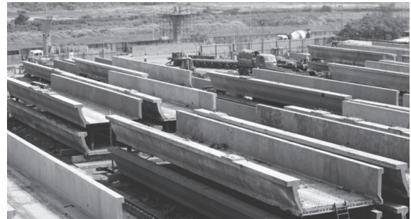
図-2 支持ブロック上の桁の保管 (写真提供：Systra)
