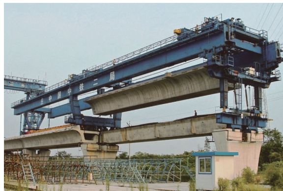
図 - 10 2 主桁用 2.3 スパン型ランチャーによる 32.7 m、4 000 kN 単線用箱桁の架設 (写真提供: BWM)
