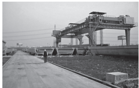
図-3 単線用U桁の大規模な保管場所 (写真提供：Systra)
