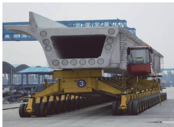
図 - 9 タイヤトローリーによる 4 000 kN 単線用箱桁の輸送 (写真提供: BWM)
