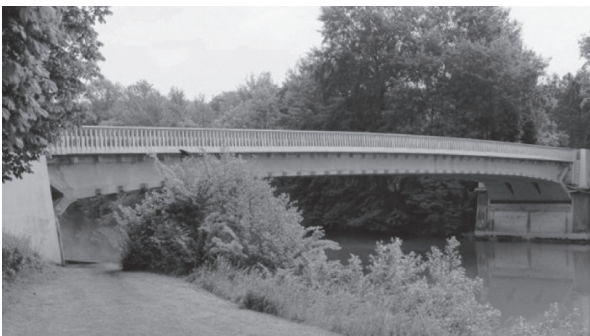
写真 - 4 現在のLuzancy橋
