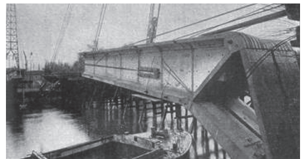
写真 - 6 架設状況 1)
