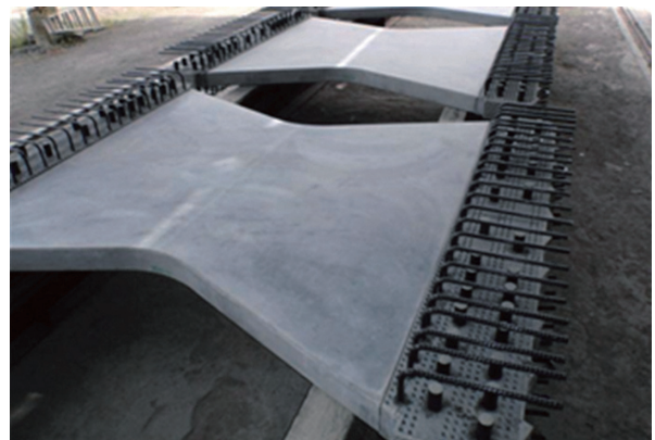
写真 - 17 仮置きされたバタフライウェブ
