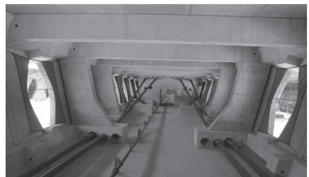
写真 - 20 箱桁内部の状況
