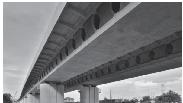
写真 - 21 完成した桶川第2高架橋
