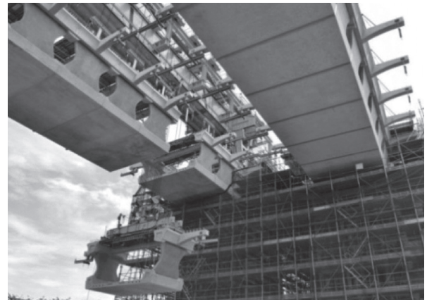
写真 - 19 U形コアセグメントのスパンバイスパン架設
