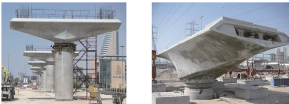
写真 - 15 橋脚横梁のプレキャスト型枠
