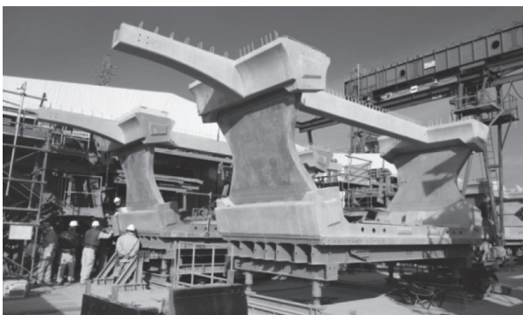
写真 - 18 バタフライウェブを用いたU形コアセグメント
