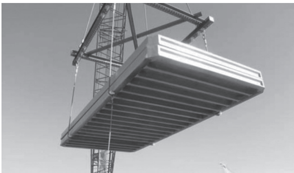
写真 - 10 運搬されるプレキャスト UFC 床版
