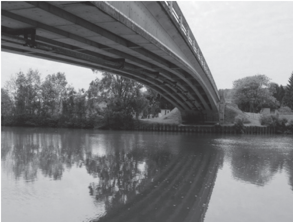
写真 - 7 現在の Changis 橋
