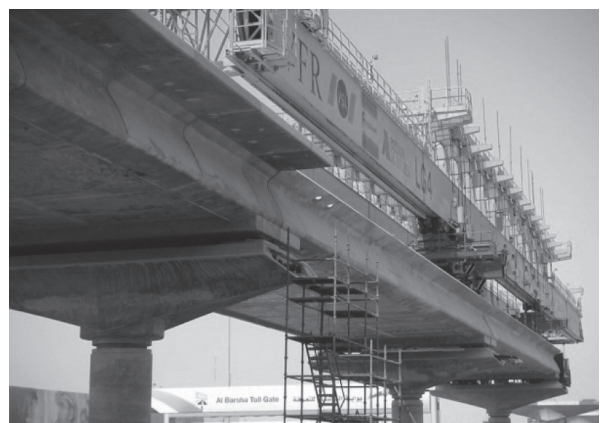
写真 - 12 主桁のスパンバイスパン架設
