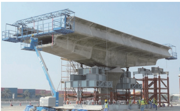
写真 - 14 スパンが長い場合の支点部
