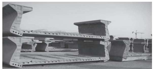
写真 - 11 標準主桁セグメントの仮置き状況
