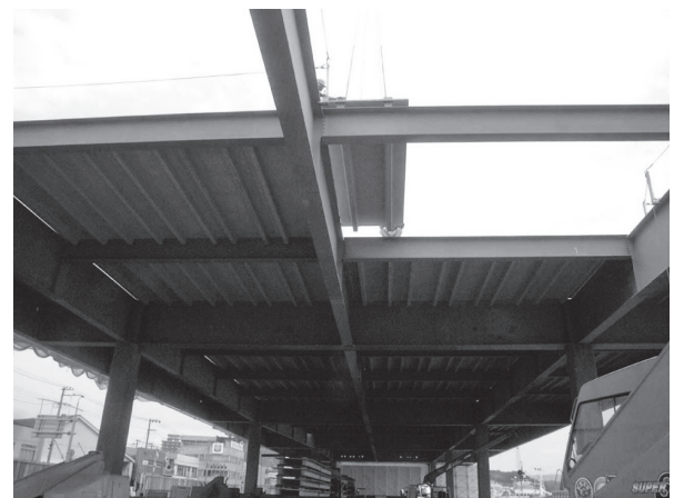
写真-1 PC合成床版架設状況
