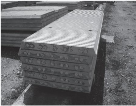
写真 - 11 PC 板上面の凹凸
