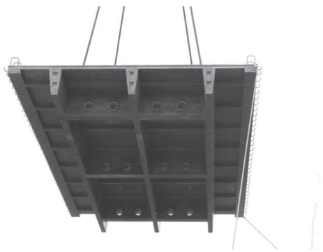
写真 - 12 UFCを用いたセグメント桁の事例
