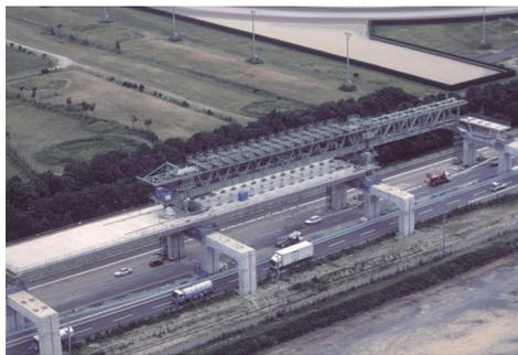
写真 - 1 プレキャストセグメント工法 (スパンバイスパン架設工法)
