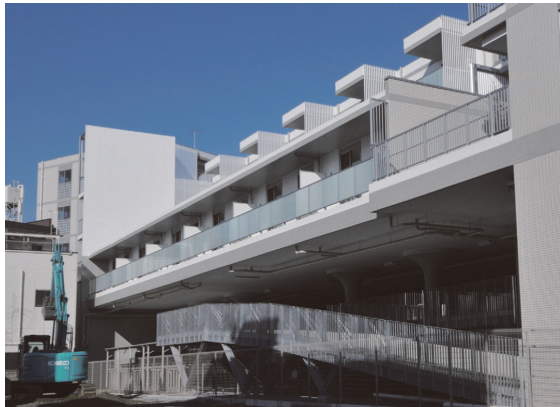
写真-14 ピロティの立面
