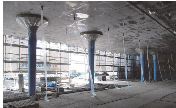
写真-13 ピロティの内部空間
