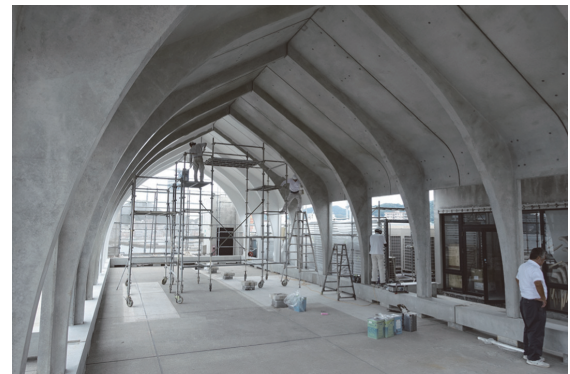
写真 - 5 上棟風景
