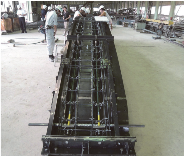
写真 - 8 型枠写真
