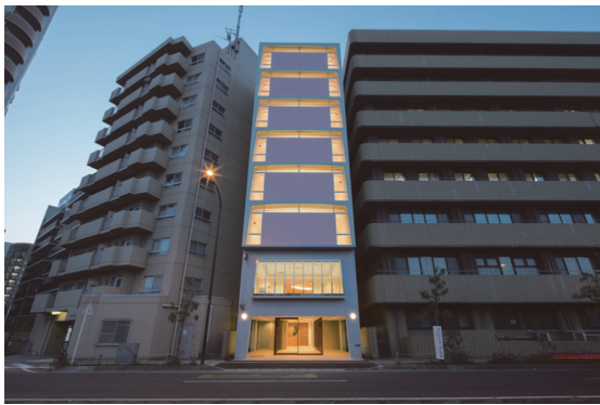
写真 - 1 ファサード全景
