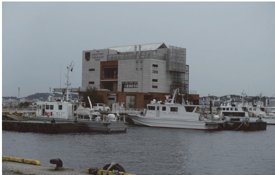
写真 - 4 港から見た建物全景
