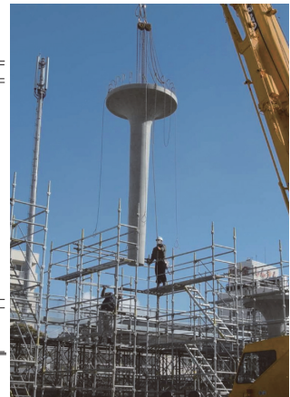
写真-15 柱の建方
