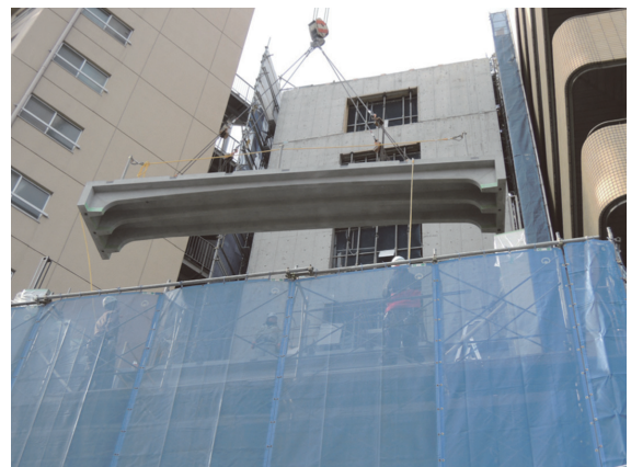
写真 - 3 PCa 床版架設状況
