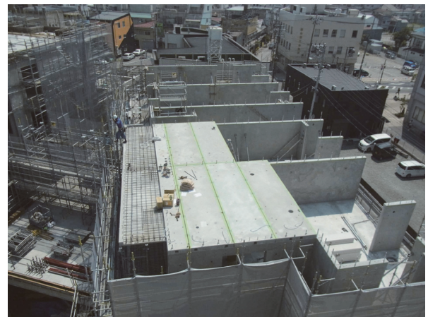
写真 - 18 PCa版の建方
