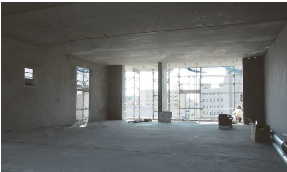
写真 - 17 建方完了時の住戸内観
