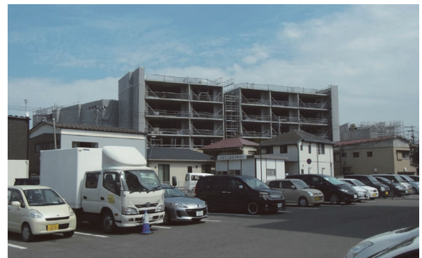
写真 - 19 上棟時の外観
