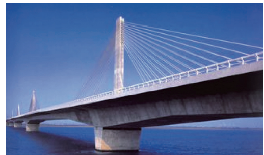
写真 - 6 揖斐川橋・木曾川橋（最重量セグメント）
