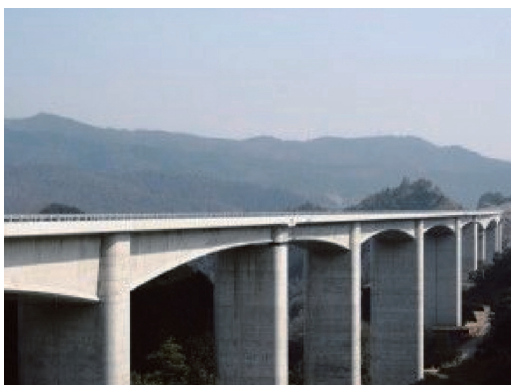
写真-9 錐ヶ瀧橋（プレテン・プレキャストウェブ） （写真提供：（株）富士ピー・エス）
