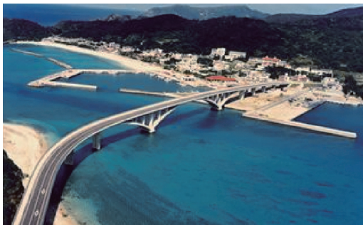
写真 - 5 阿嘉大橋（プレキャストのアーチ橋）
