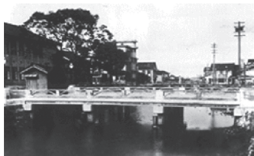
写真 - 1 建設当時の長生橋 (写真提供：(株)ピーエス三菱)
