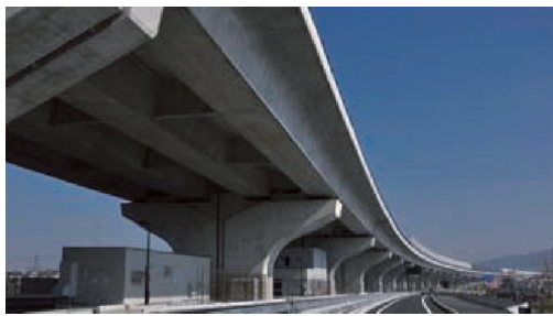
写真-8 茄子作地区高架橋（連続U型げた） （写真提供：三井住友建設（株））
