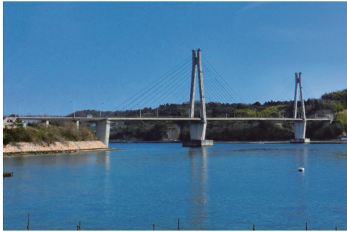
写真 - 4 大芝大橋（プレキャストの斜張橋） （写真提供：広島県）
