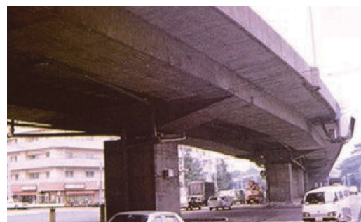
写真 - 3 目黒架道橋（プレキャストの張出し架設）
