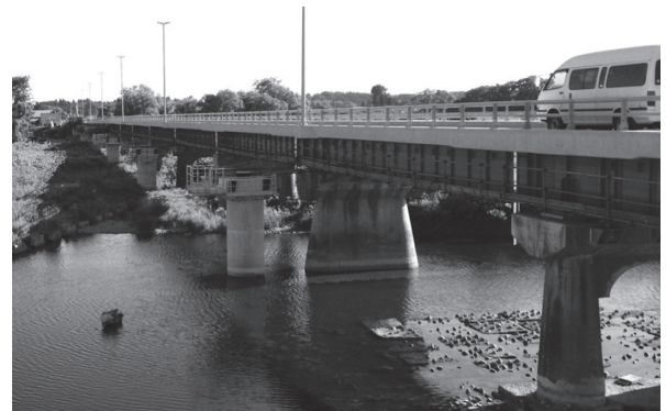
写真 - 19 歩道橋下部工施工完了状況
