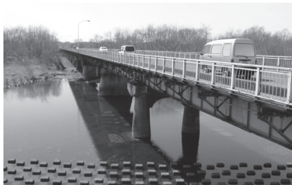
写真 - 1 九年橋の既設橋梁
