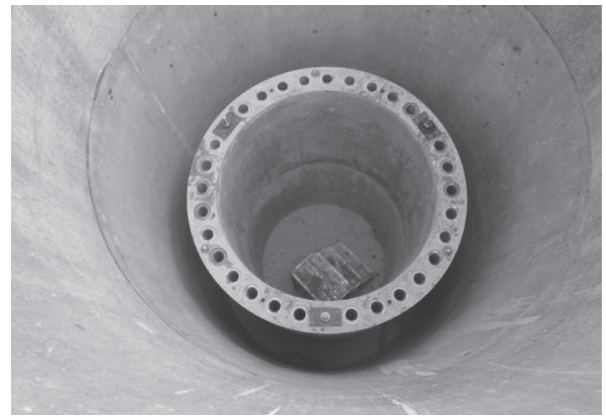
写真 - 18 橋脚部の施工状況
