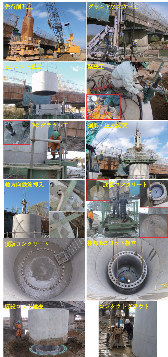
写真 - 3 主要な工種の施工状況
