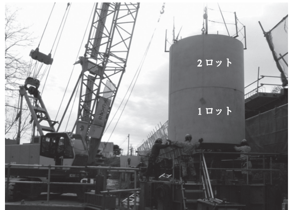
写真 - 14 仮設ロット（2 ロット）一括組立て状況
