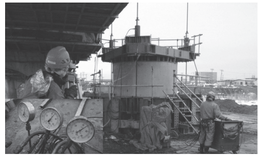
写真-11 円環断面加圧地盤調査試験状況
