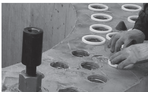
写真 - 5 溝無でのシースパッキン設置状況
