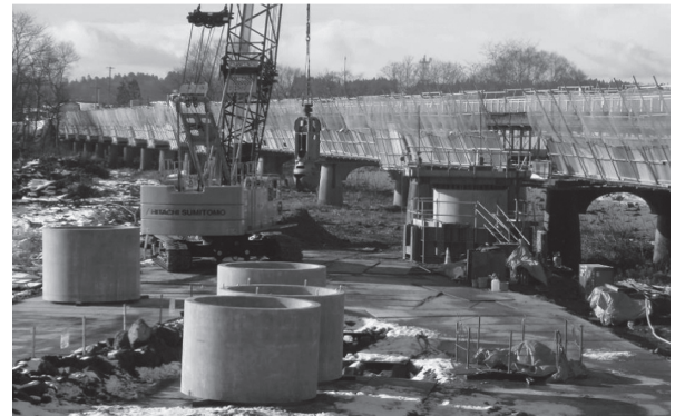
写真 - 2 施工状況
