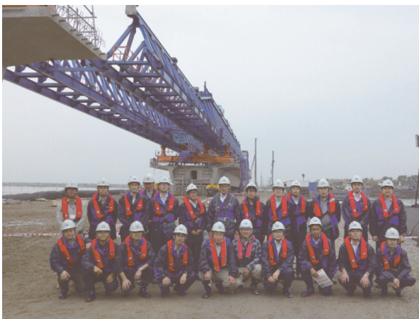
写真-5 スパンバイスパン架設工法の架設桁と参加者
