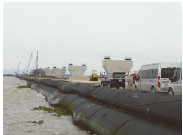
写真-7 アクセス道路の盛土を補強するジオチューブ
