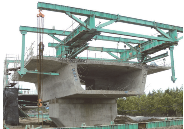
写真-6 片持ち張出し架設の状況
