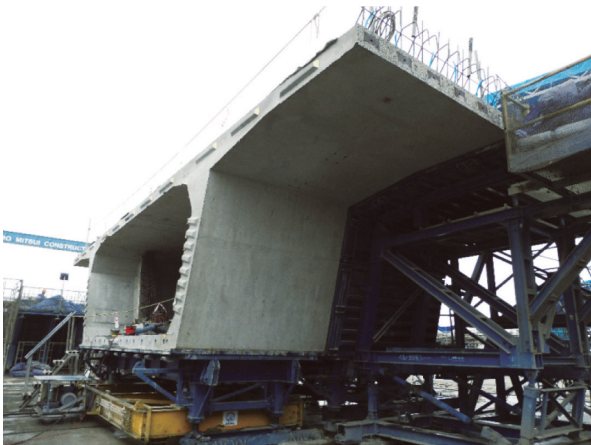
写真-4 セグメントの製作状況
