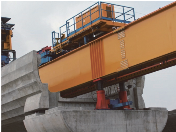
図 - 15 下支え式架設桁の後方張出しの電動桁受
