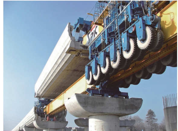
図 - 16 門型キャリアによる主桁配置状況
