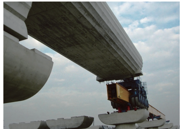
図 - 17 下支え式架設桁の配置状況
