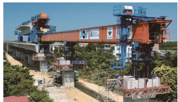
図 - 18 複線用箱桁用の強固な橋上フレーム (写真提供：VSL)
