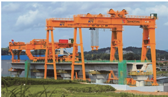
図 - 19 高架上架設ライン用のフルスパン架設プラットフォーム
