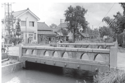
写真 - 1 建設当時の対象橋梁「十郷橋」
