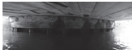
写真 - 2 「十郷橋」の桁下状況
