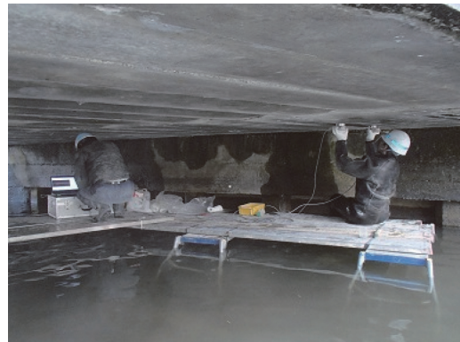
写真 - 3 広帯域超音波法によるグラウト調査
