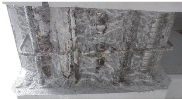
写真 - 1 鉄筋の腐食および PC 鋼材破断状況
