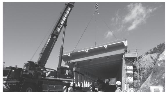
写真 - 4 クレーンによる架設状況
