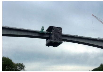
写真 - 7 移動作業車による中央閉合
