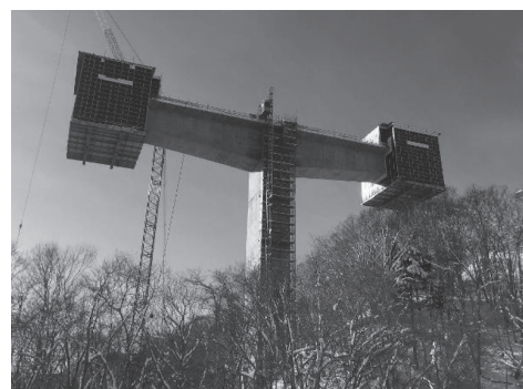
写真 - 3 防寒養生状況
