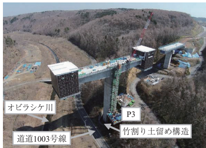
写真 - 6 道道上の施工状況
