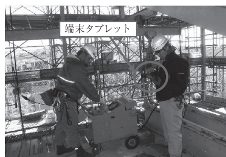
写真-4 IT端末を用いた緊張管理状況
