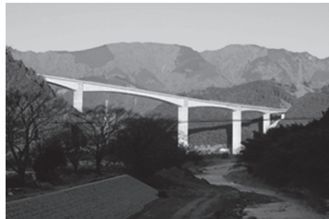
写真 - 8 完成写真 (下流側より)
