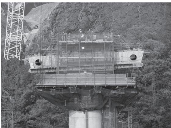
写真 - 9 ハーフプレキャストによる柱頭部施工
