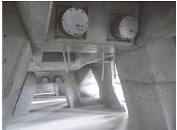
写真 - 6 桁内の斜材定着部
