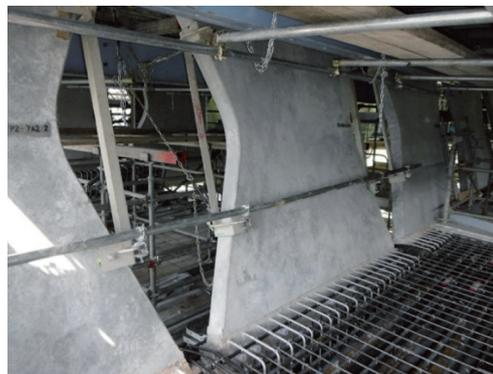
写真 - 8 バタフライウェブセット完了
