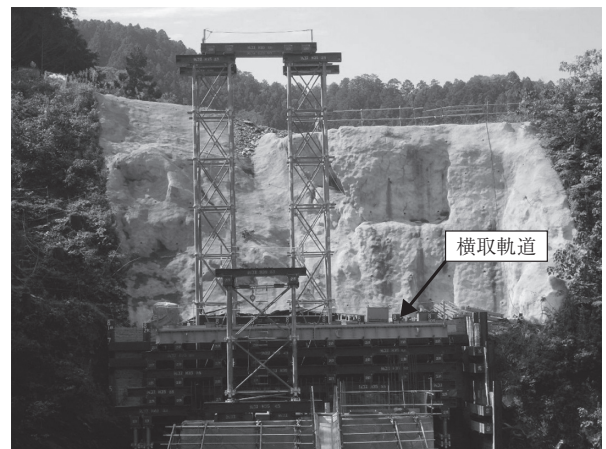
写真 - 6 横取り軌道
