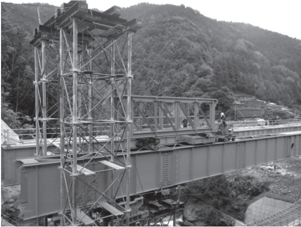
写真 - 1 手延桁解体状況
