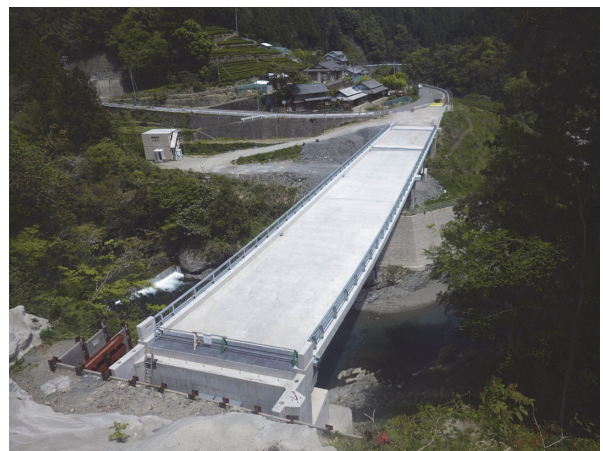
写真 - 14 完成全景（上面より）
