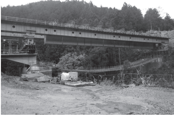
写真 - 2 セグメント組立状況 ①
