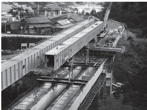
写真 - 7 架設桁解体状況
