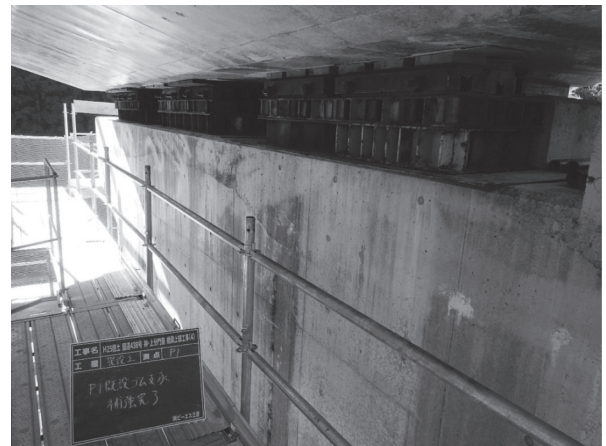
写真 - 5 支保周り補強対策
