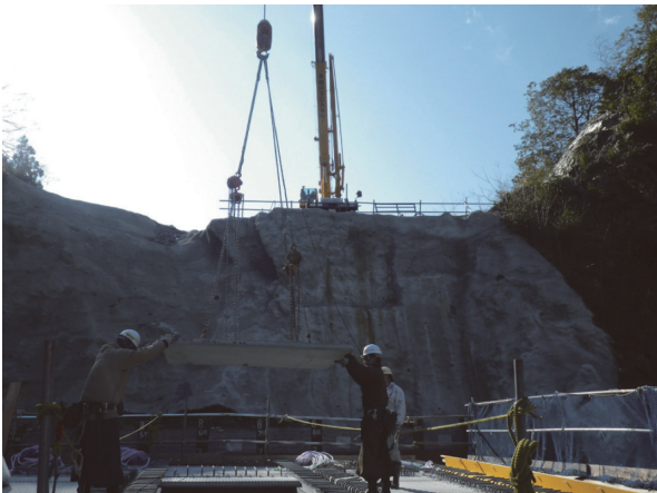
写真 - 12 PC 板敷設状況
