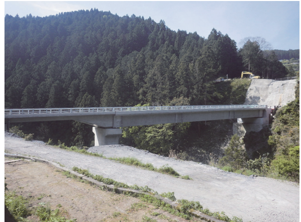
写真 - 13 完成全景（側面より）
