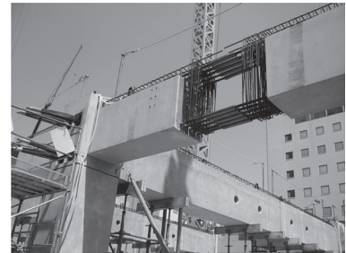
桁行方向 RC 梁の現場継手
