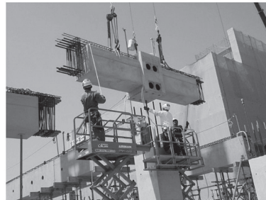
桁行方向 PCaRC 大梁の架設
