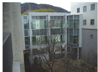
渡り廊下 (鉄骨造)
