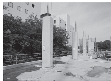
PCa 柱の架設
