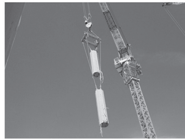
PCa 柱の架設 (2 ピース楊重)
