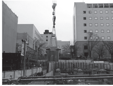
免震ブロックの架設
