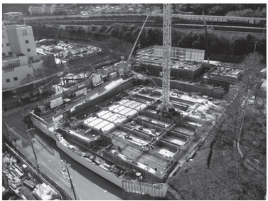
1階 RC 梁の施工状況
