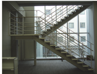
吹抜部の鉄骨階段
