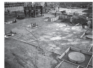
左上側が半固定接合、右下側は鋼管巻き
