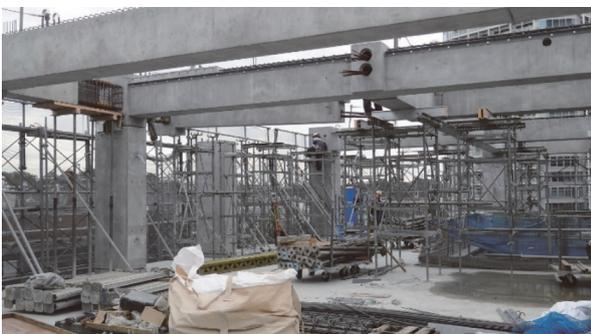
写真 - 8 外周柱側仕口部の逆挿し工法
