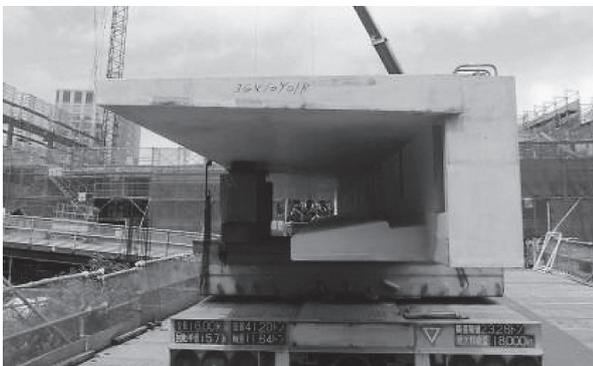
写真 - 6 エントランス部 羽根梁部材
