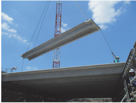
写真 - 16 リブ付き PC スラブ架設状況
