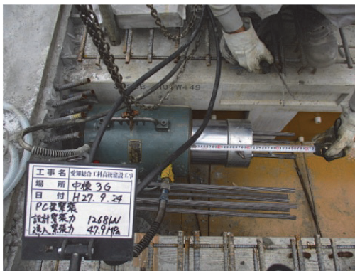
写真 - 17 後施工区間緊張状況
