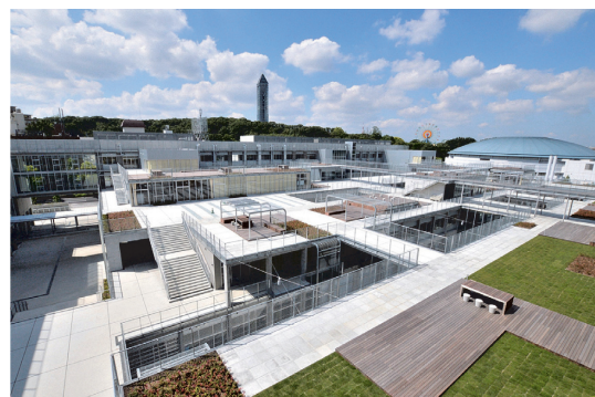
写真 - 5 屋上広場
