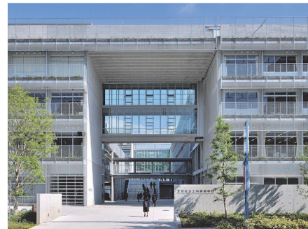
写真 - 8 渡り部分のエキスパンション・ジョイント (図 - 2 の矢視 ③)
