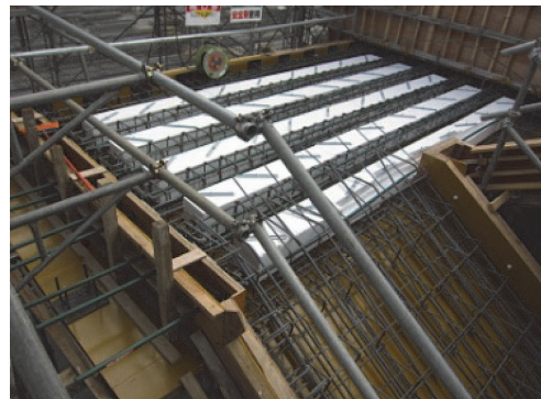
写真 - 20 踊場片持ちスラブ施工状況
