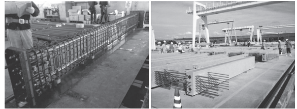
配筋 ストック
