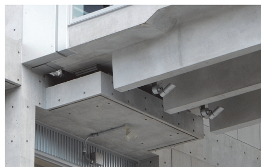
写真 - 10 渡り廊下支承部
