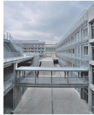
写真 - 6 細柱からなる鉛直フレーム (図 - 2 の矢視 ①)
