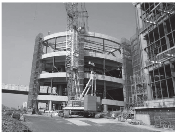
写真 - 8 ランプウェイ支保工
