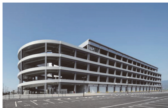
写真 - 1 GLP 鳴尾浜（外観北東面）
