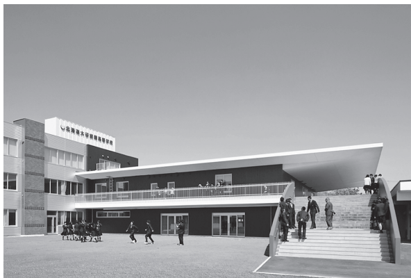
写真 - 5 8.75m 跳ね出し半屋外の無柱多目的広場
