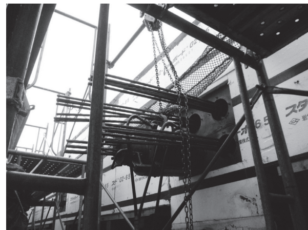
写真 - 4 PC ロングスパン梁の緊張状況
