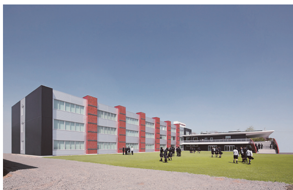
写真 - 1 建物外観
