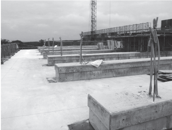
写真 - 2 片持ちスラブ上より撮影した施工状況
