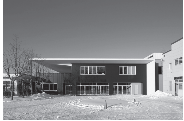
写真 - 6 8.75m 跳ね出し半屋外の無柱多目的広場 —完成写真—
