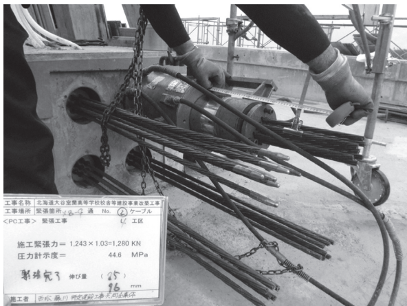
写真 - 3 PC キャンティレバー梁の緊張状況
