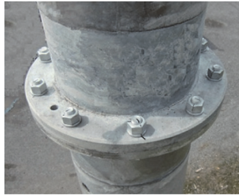
写真 - 2 継ポール継手構造
