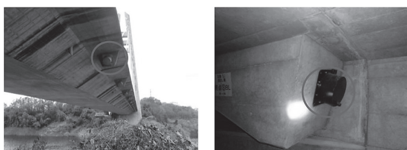
斜材定着部を箱桁内に収納(本橋)
