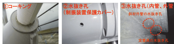
写真 - 3 斜材定着部の点検ポイント箇所
