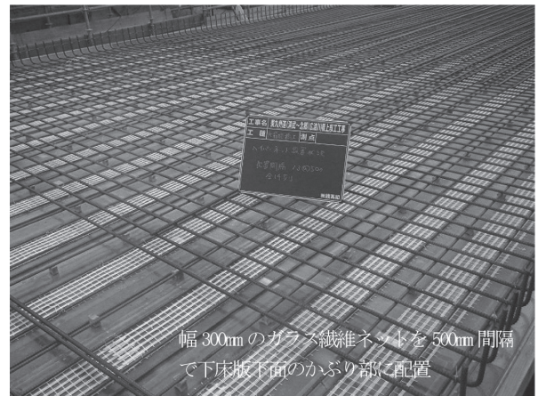
写真 - 6 ガラス繊維ネットの配置状況
