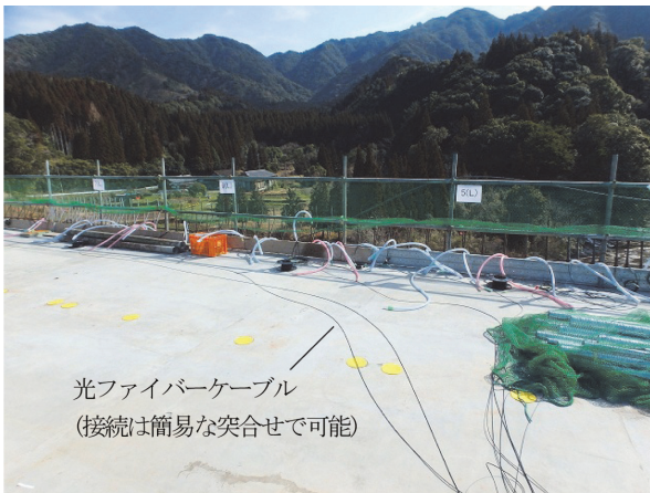
写真 - 11 グラウト充填検知センサーの延長用接続配線
