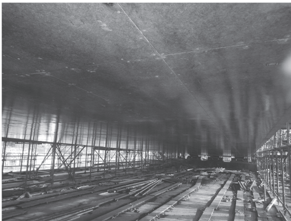
写真 - 7 固定支保工解体時の主桁下面状況
