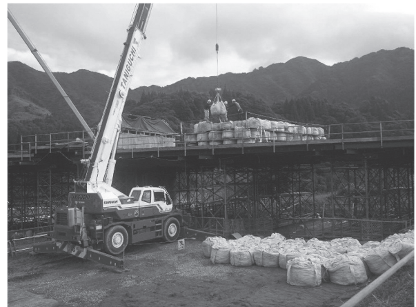
写真 - 3 支保工への実荷重載荷試験状況
