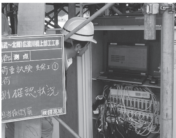
写真 - 4 支保工沈下量の現地確認状況
