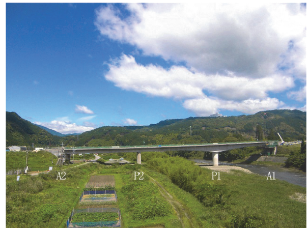
写真 - 12 主桁完成時全景
