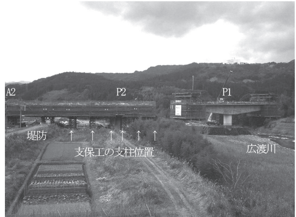
写真 - 2 固定支保工架設部の全景（写真左側）
