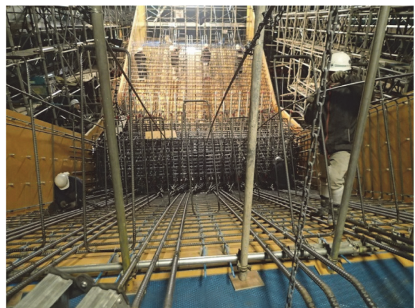
写真 - 2 V脚部配筋状況
