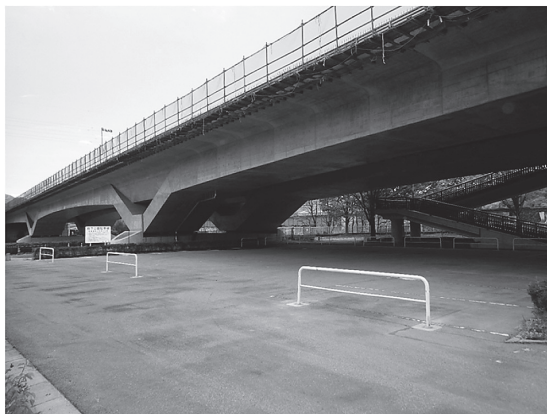
写真 - 3 全景（A2側側面より）
