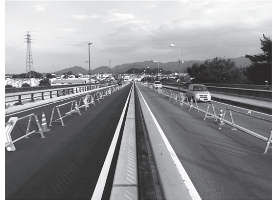
写真 - 5 暫定供用状況（橋面上A2側より）
