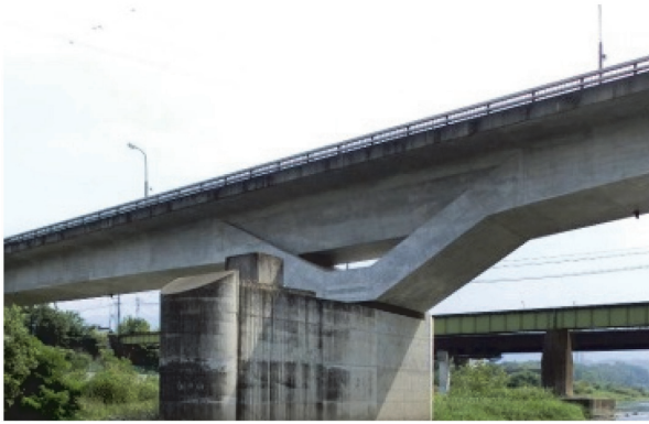
写真 - 1 既設橋 P1 部
