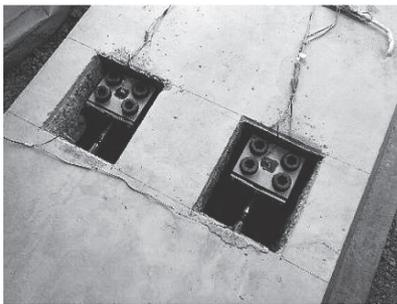
写真 - 6 中間定着装置の設置
