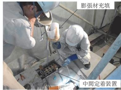
写真 - 10 中間定着装置の設置
