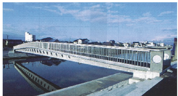
図-3 UFCが日本で初めて適用された歩道橋 13) (酒田みらい橋)
