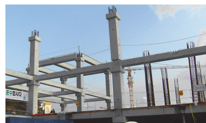
写真-2 工法の現場施工例
