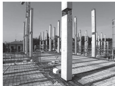
写真-1 従来の2層1節PCa柱 (www.archiproducts.com)
