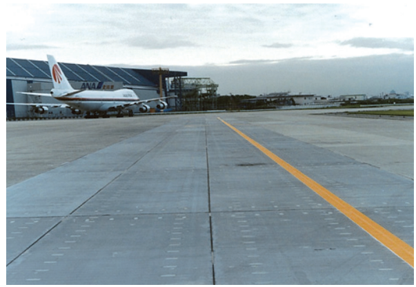
写真 - 5 大阪国際空港誘導路
