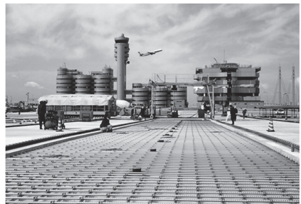
写真 - 1 東京国際空港エプロン工事
