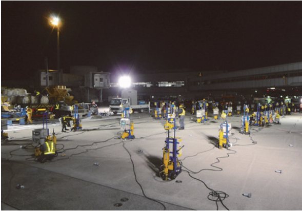
写真 - 3 リフトアップ状況
