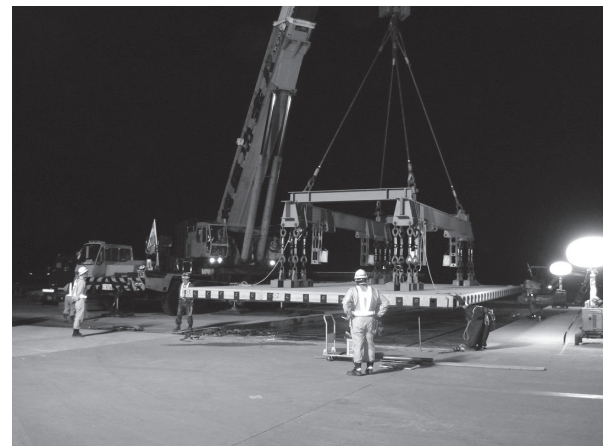
写真-7 仮据え付けの状況
