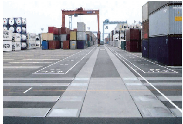
写真 - 6 トランスファークレーンの走行路
