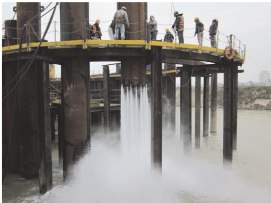
写真 - 1 ウォータージェットパイプロ工法を採用したニャタン橋の鋼管矢板基礎
