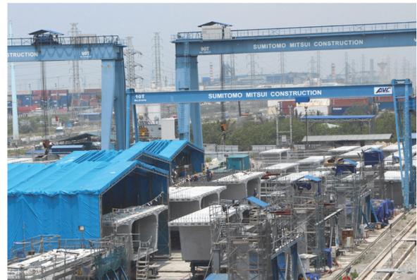
写真-4 ショートラインマッチキャスト方式で製作するラックフェン橋のセグメント
