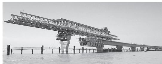
写真 - 8 海上部を突き進むセグメント設桁、架設終了は10月初旬
