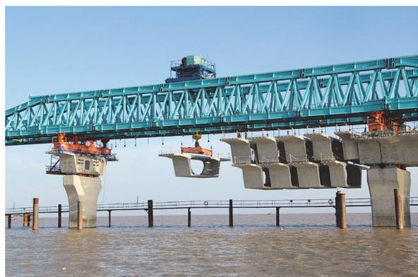
写真-6 約80tのプレキャストセグメントを19個吊下げ1径間を完成させるスパンバイスパン架設
