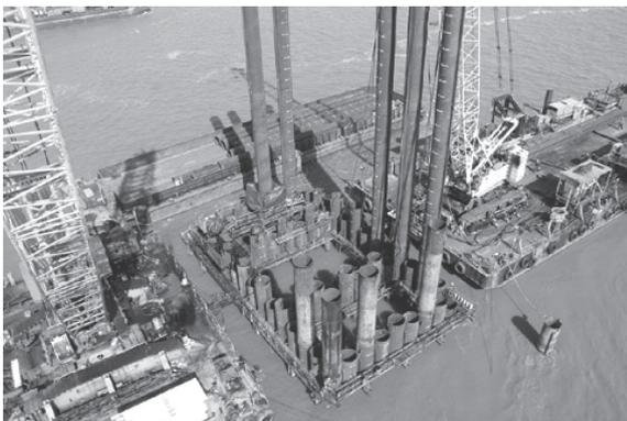
写真-7 2組の台船上大型クレーンで打ち込まれる鋼管矢板
