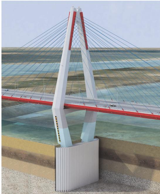
図 - 2 3次元的に変化するニャタン橋の主塔
