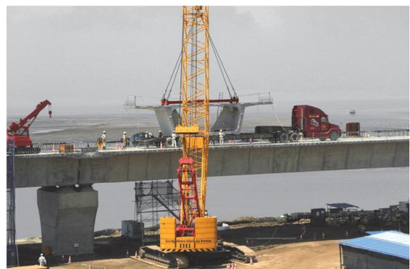
写真-5 セグメントを完成した主桁の橋面を利用して架設桁まで運搬する海上部施工
