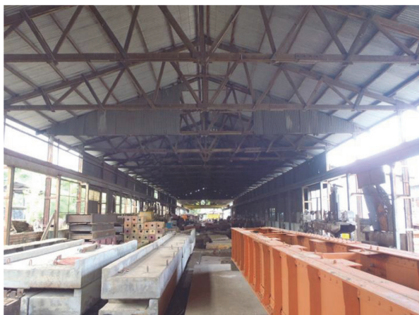
写真-3 PC桁と鋼桁の製作
