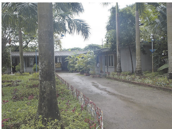
写真-1 マルワゴン工場 オフィス棟
