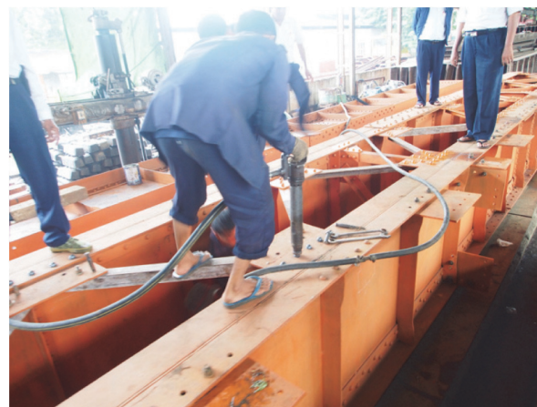
写真-4 リベット打ち作業
