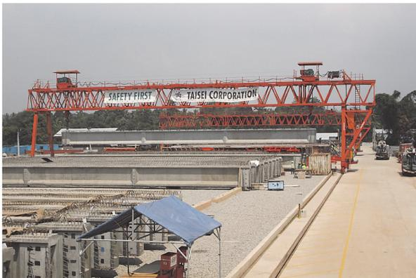
写真 - 2 100T吊り門型クレーンによるPC桁移動状況(奥が10Tクレーン)
