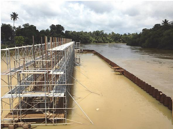
写真 - 6 半川締切水没状況
