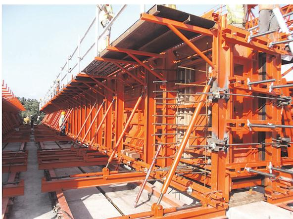
写真 - 3 PC桁鋼製型枠
