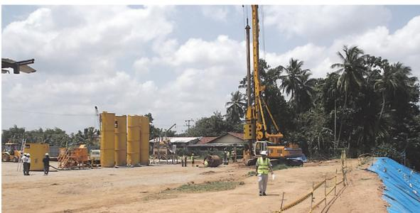
写真 - 7 パワー機による場所打ち杭の施工
