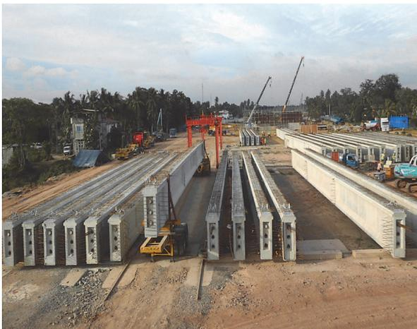
写真 - 4 桁仮置き状況（高架橋区間上）
