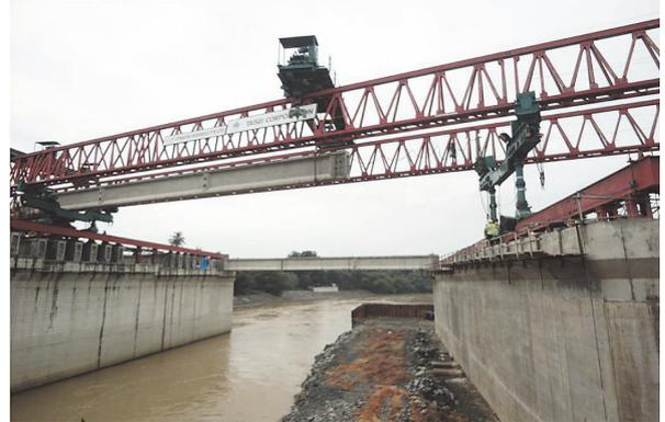
写真 - 8 移動式架設桁による PC 桁架設状況
