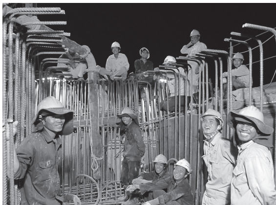
写真 - 4 深夜のコンクリート打ち
