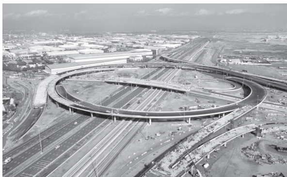
写真 - 6 ドバイインターチェンジ NO.8 改良工事 （撮影 酒井 貴之）
