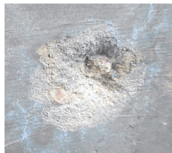
写真 - 2 実構造物でみられるポップアウト
