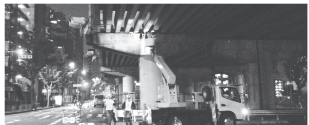
写真-3 点検状況
