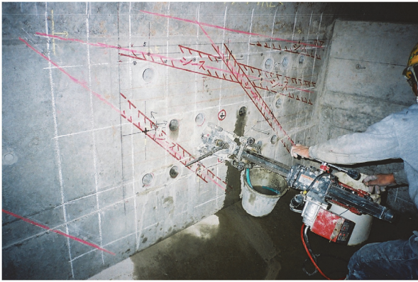
写真 - 1 主ケーブル位置および削孔状況
